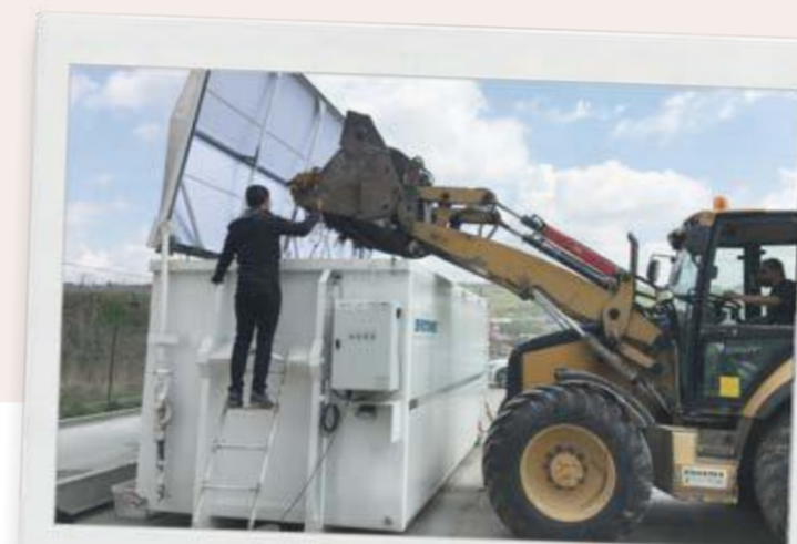
ČADCA - INŠTALOVANIE CSC KONTAJNERA
